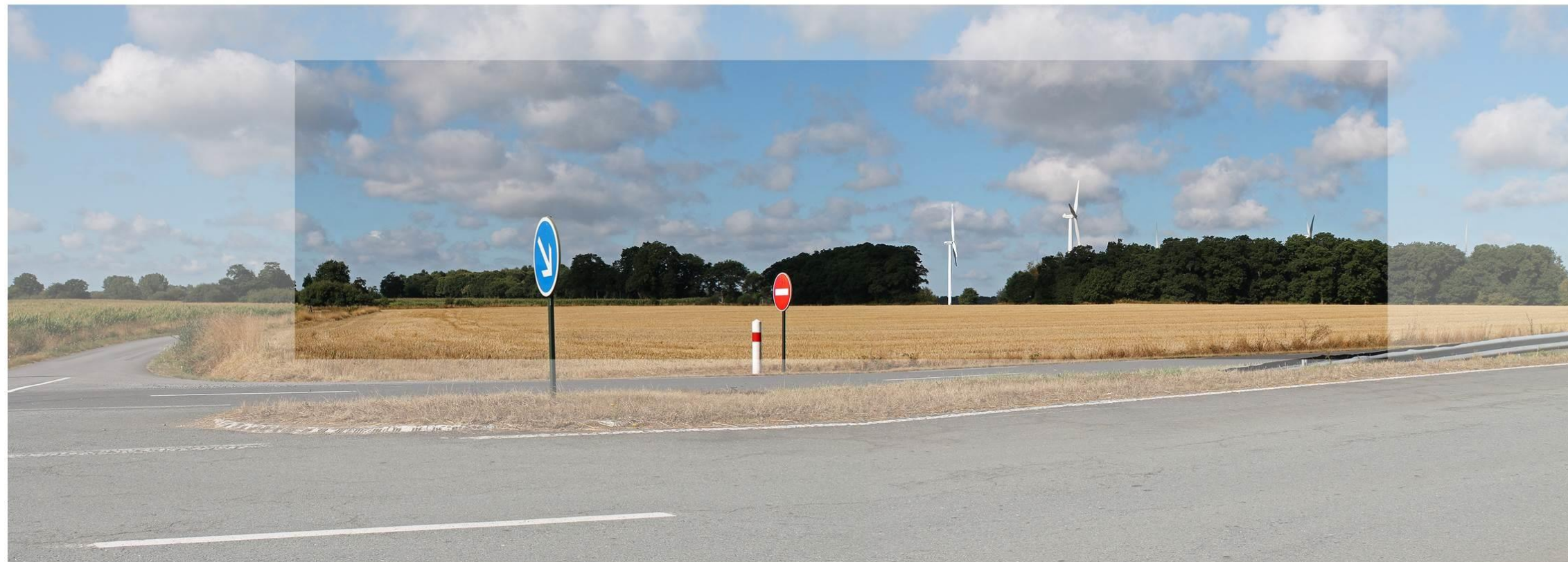
Vue panoramique - Etat initial
